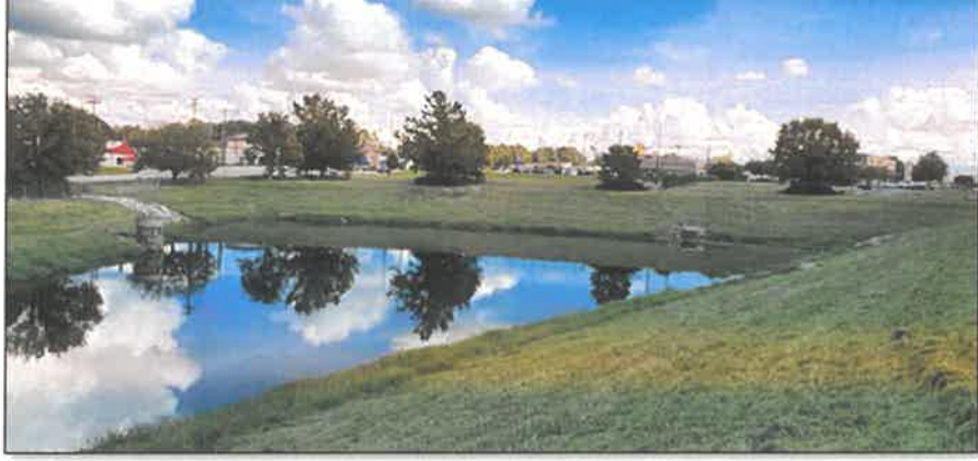
Şekil 10: Yağmursuyu öteleme havuzu örneği
