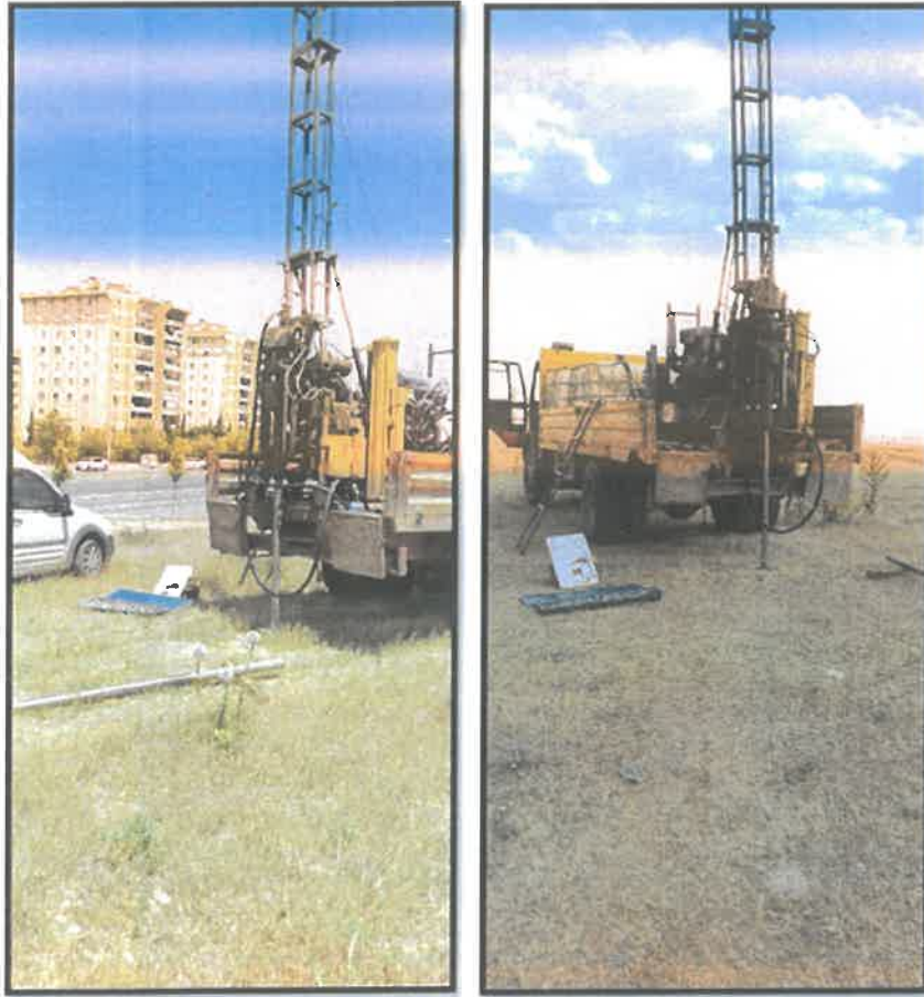
Şekil 18 Temel Sondaj Kuyusu Fotoğrafı
