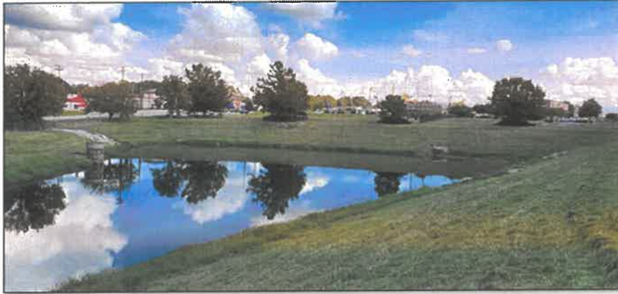
Şekil 10: Yağmursuyu öteleme havuzu örneği
