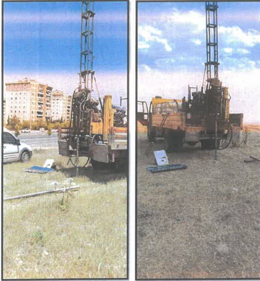
Şekil 18 Temel Sondaj Kuyusu Fotoğrafı
