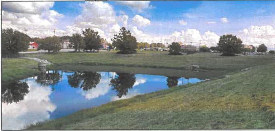
Şekil 10: Yağmursuyu öteleme havuzu örneği
