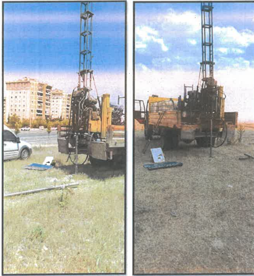
Şekil 18 Temel Sondaj Kuyusu Fotoğrafı
