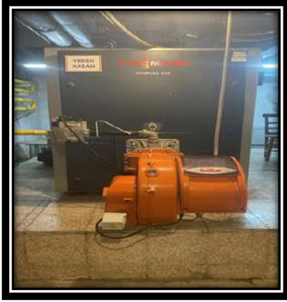
GBB Hizmet Binası Kazan Bakım Onarım İşi
