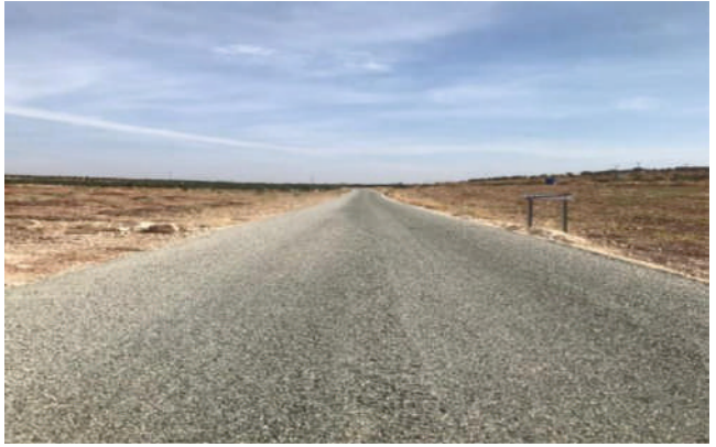
Oğuzeli Kavunluk Mahallesi ile Tınazdere Mahallesi Arası Bağlantı Yolları Sathi Kaplama
