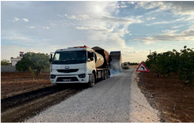
Nizip Kurucahöyük Mahallesi ile Akkuyu Mahallesi Arası Bağlantı Yolları Sathi Kaplama
