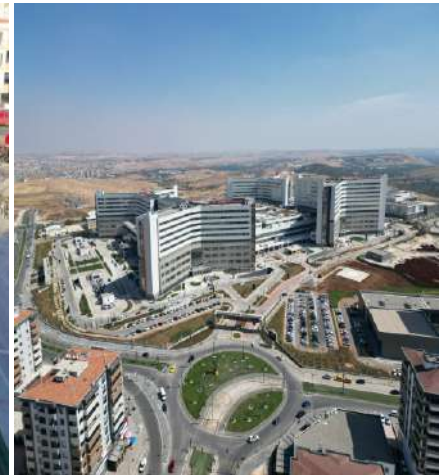
Şehir Hastahanesi Kavşak Kaldırım ve Refüj Çalışmaları
