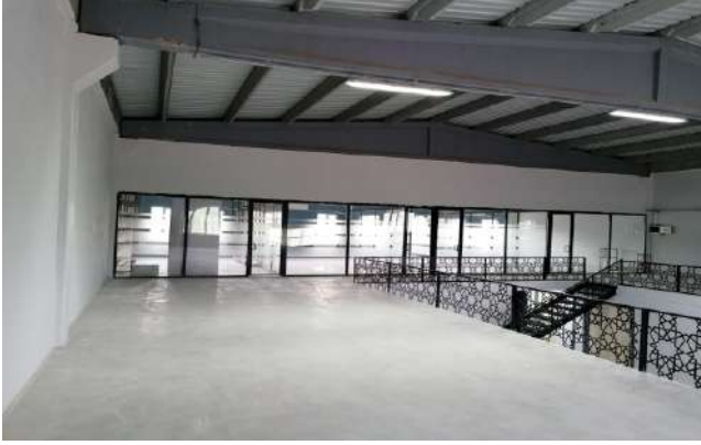
GBB Asfalt Şantiyesi Bakım Onarım Yapım İşi
