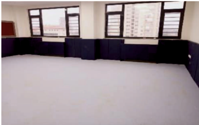
Uygulama Okulu Tadilatı yapım Bakım ve Onarım Yapım İşi
