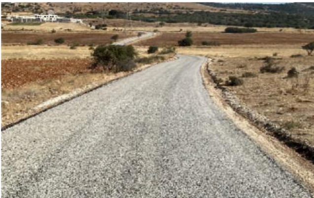
Bağbaşı Mahallesi Kahramanmaraş Bağlantı Yolu Sathi Kaplama
