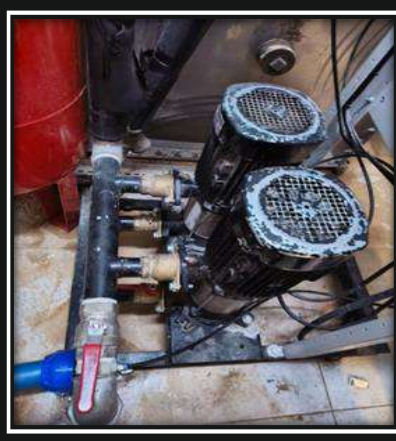
"Yüzme Havuzu Hidrofor Değişimi İşi"
