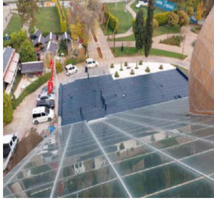
Çatı Onarım Çalışmaları
