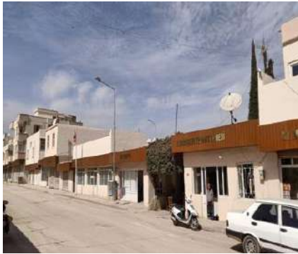
Karkamış İlçesi Dış Cephe Yenileme
