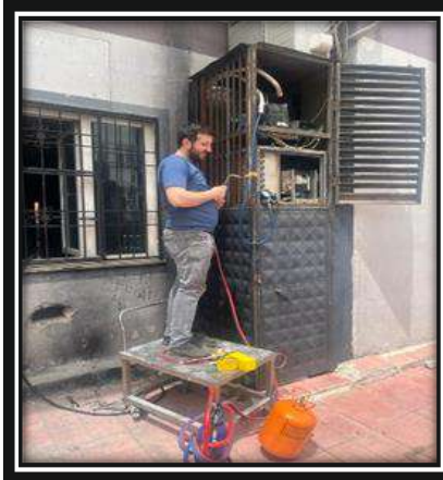
"Soğuk Hava ve Kompresör Değişimi İşi"
