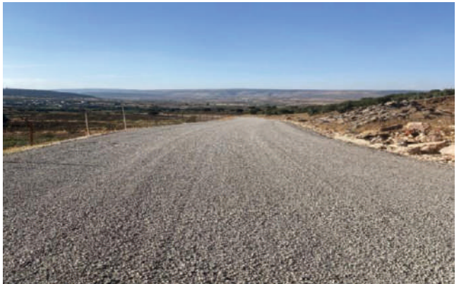
Yavuzeli Halilbaşlı- Sarıbuğday- Bakırca- Ballık Mahalleleri Bağlantı Yolları Sathi Kaplama
