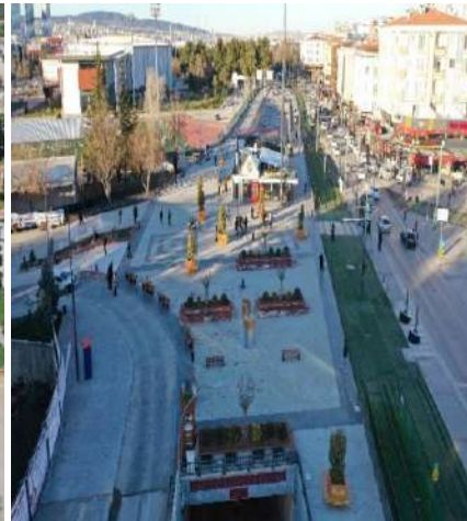
Üniversite Meydanı Kaldırım Çalışması
