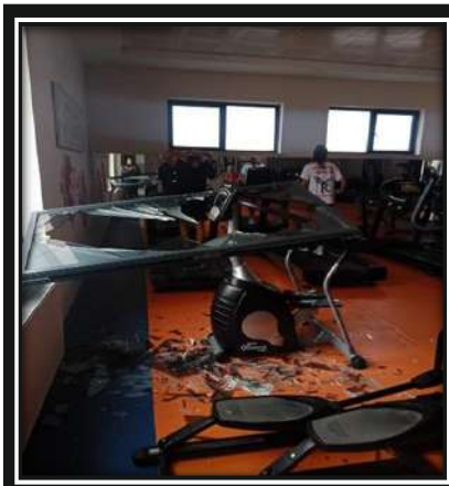
"GBB Hizmet Binası ve bağlı birimlerin Dış Cephe Cam Değişimi İşi"
