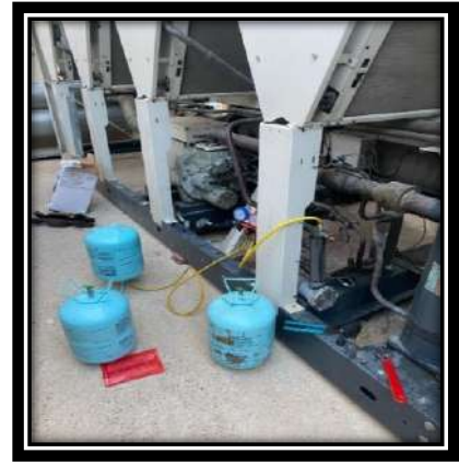
GBB hizmet Binası Chiller Soğutucu sistemine Gaz Basımı İşi
