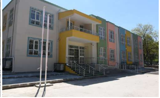
Alleben Mahallesi Kreş Binası Bakım Onarım Yapım İşi
