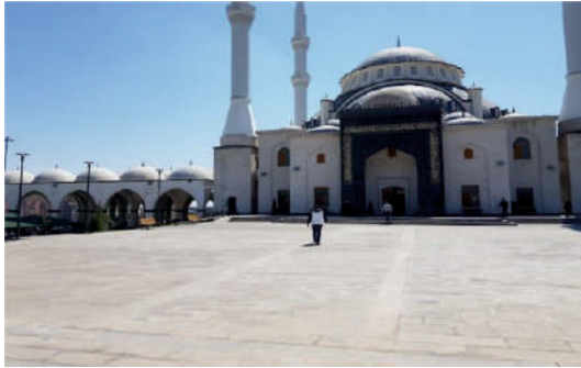
Şireci Camii Mezarlık Ek Bina
