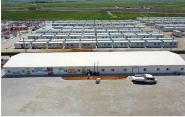
Nurdağı İlçesi Büyükşehir Belediyesi Okul ve Konteyner Kent Alanı Kaldırım Çalışması
