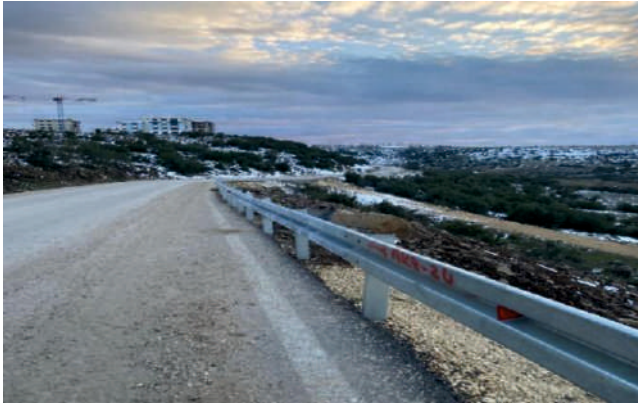
Gaziantep İl Sınırları İçerisinde Oto Korkuluk Yapım Çalışması
