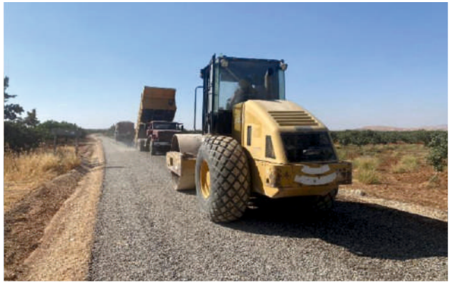
Nizip Yağmurlan Mahallesi ile Yarımtepe Mah. Arası Bağlantı Yolları Sathi Kaplama
