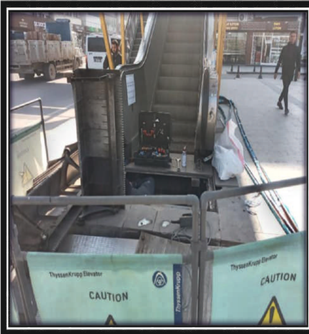
"Yürüyen Merdiven Bakım Onarım İşi"
