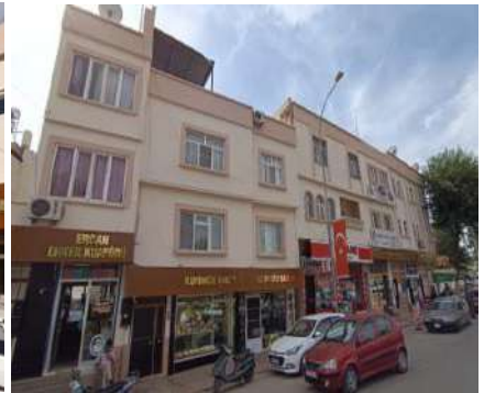
Oğuzeli İlçesi Dış Cephe Yenileme
