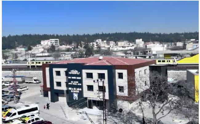
GBB İnayet Topçuoğlu Hastanesi Diş Kliniği Bakım Onarım Yapım İşi
