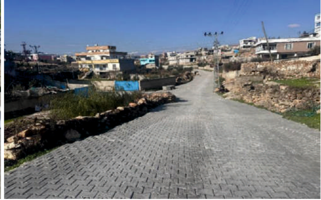
Yavuzeli Sarılar Mahallesi Kaldırım Çalışması
