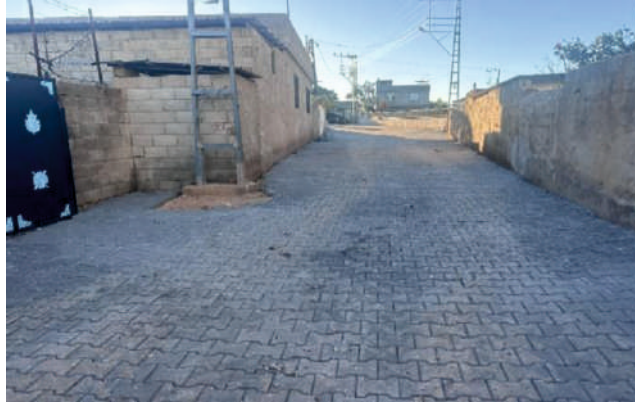
Yavuzeli Saraymağara Mahallesi Kaldırım Çalışması
