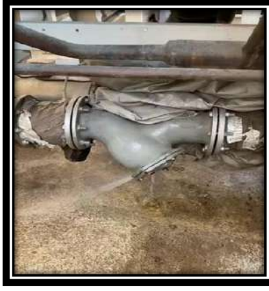
GBB Hizmet Binası Chiller Su Boşaltım İşi
