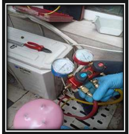
"Klimaya Gaz Basımı İşi"
