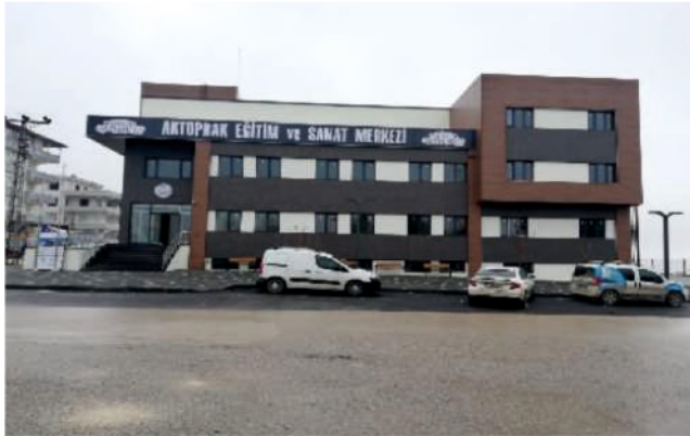
Aktoprak Mah.Sosyal Tesis Tadilatı, Bakım ve Onarım Yapım İşi
