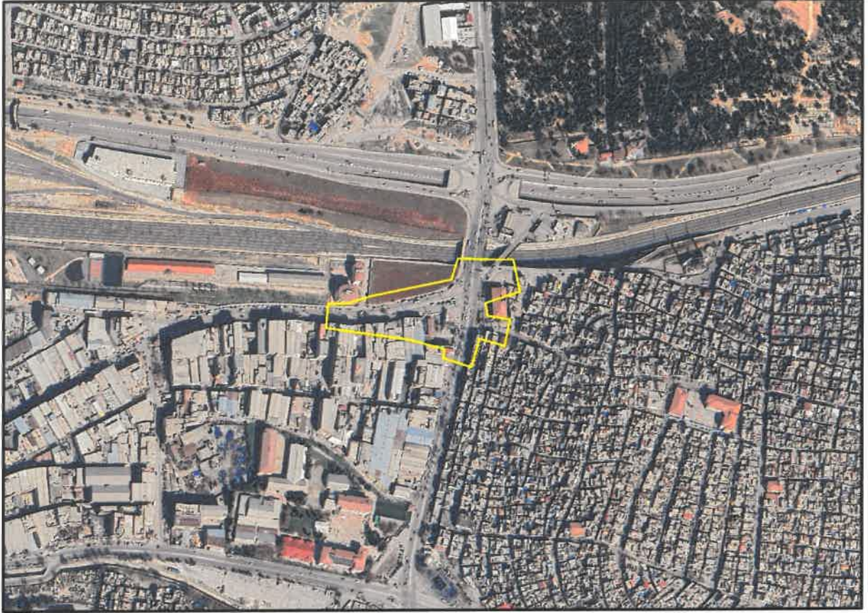
řekil 1: akmak Mahallesi Planlama Alanı Konumu
