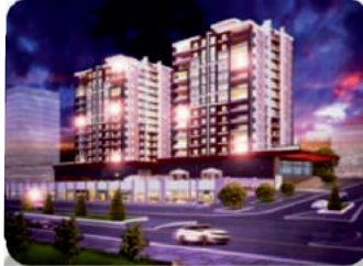
981 ADA 2 PARSEL "TICK" 3 BLOKLU (A-B-C) ADA ÇALIŞMASI
