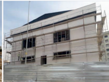
Şahinbey İlçesi Yeşilevler Mahalle Tipi Spor Salonu Yapımı
