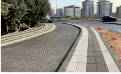
İbrahimli 2 Batıkent Kavşağı Kaldırım Çalışmaları
