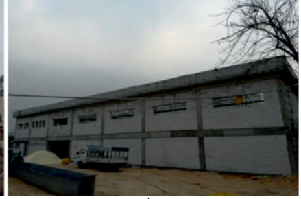
Şehitkamil İlçesi 8 Şubat Mahalle Tipi Yüzme Havuzu Yapımı
