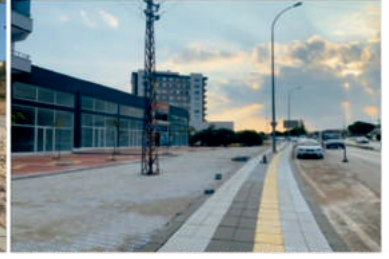
Adliye Yolu Yeni Stadyum Kavşağı Kaldırım Çalışmaları
