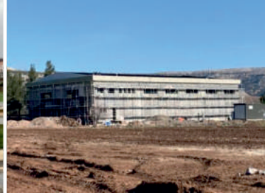
Araban İlçesi Yüzme Havuzu Yapımı
