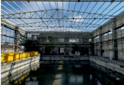
Nizip İlçesi Yüzme Havuzu Yapımı
