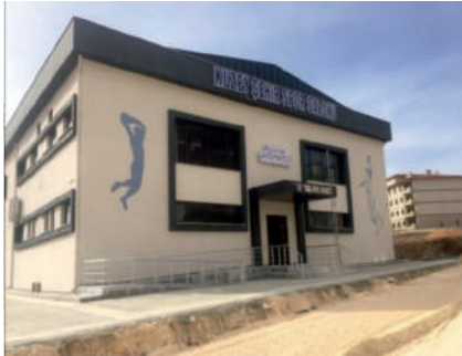
Şehitkamil İlçesi Kuzeyşehir Mahalle Tipi Spor Salonu Yapımı
