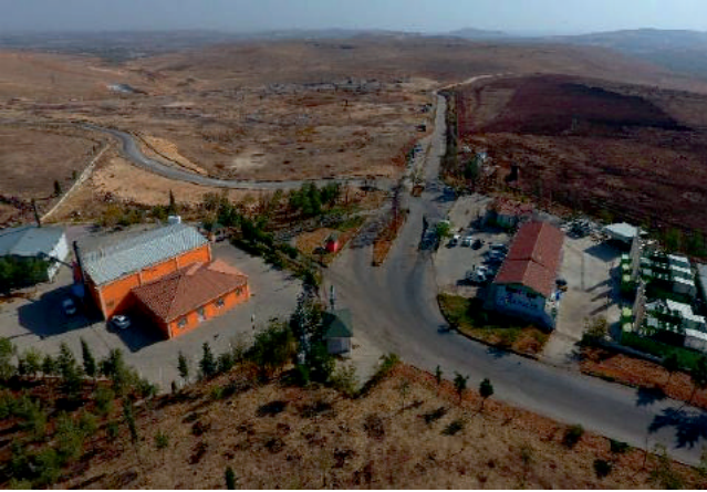
Merkez Katı Atık Sahası
