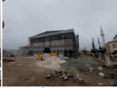
Şehitkamil İlçesi Beykent (Gaziler) Mahalle Tipi Yüzme Havuzu Yapımı
