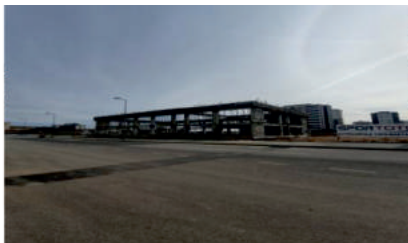
Şehitkamil İlçesi Fıstıklık Mahalle Tipi Spor Salonu Yapımı
