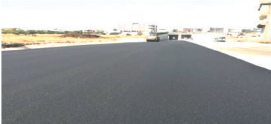
Taşlıca Mahallesi Gaziray Köprü Alt Yolu
