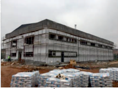
Şehitkamil İlçesi Gazikent Mahalle Tipi Yüzme Havuzu Yapımı
