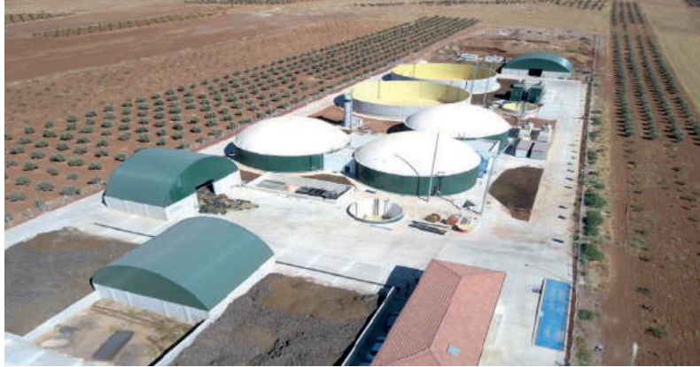
Oğuzeli Biyogaz Enerji Santrali
