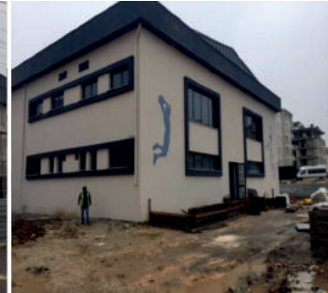
Şahinbey İlçesi Ertuğrul Gazi Mahalle Tipi Spor Salonu Yapımı
