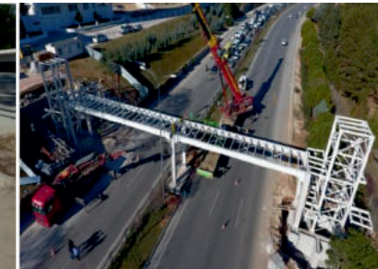
Tugay D-400 Üst Geçit Yapım İş
