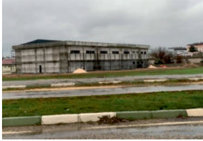
Yavuzeli İlçesi Yüzme Havuzu Yapımı
