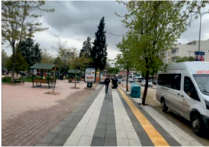
Tüfekçi Yusuf Bulvarı Kaldırım Çalışması
