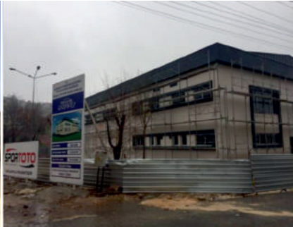
Şahinbey İlçesi Dumlupınar Mahalle Tipi Spor Salonu Yapımı
