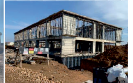
Karkamış İlçesi Yüzme Havuzu Yapımı
