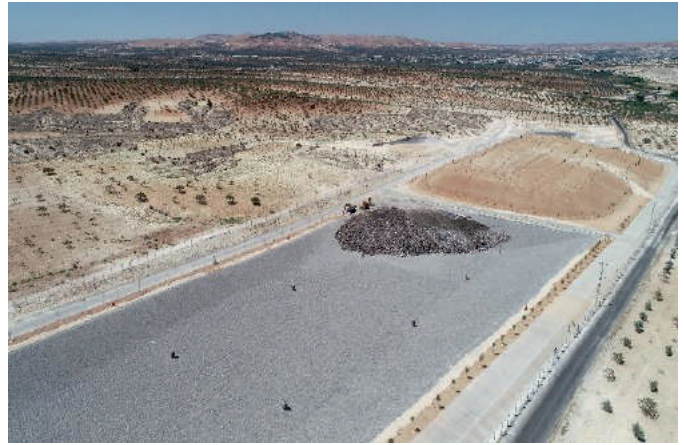
Nizip Katı Atık Sahası
