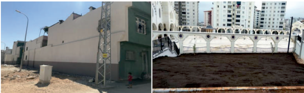
Dış Cephe Yenileme Çalışmaları
