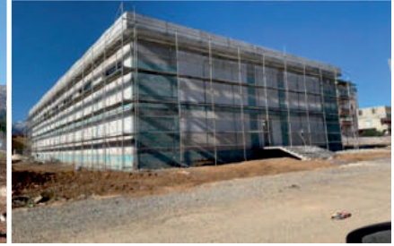
İslahiye İlçesi Yüzme Havuzu Yapımı
