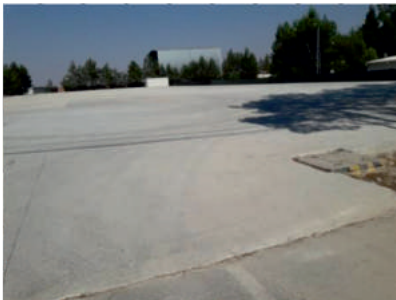
Karkamış İlçesi Soylu Bölgesinde Helikopter Pisti ve Sert Zemin Düzenlenmesi Yapılmıştır.
