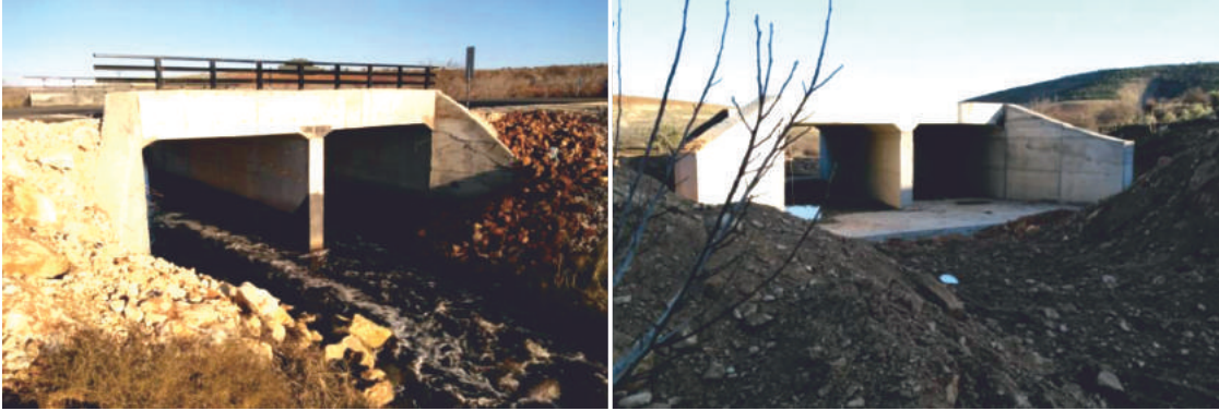
Gaziantep Bilek Mahallesi Menfez Yapım İşi
