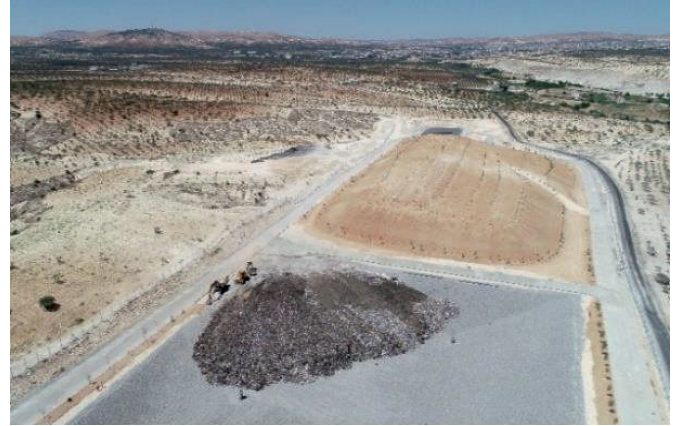
Nizip Katı Atık Sahası Rehabilitasyon Alanı
