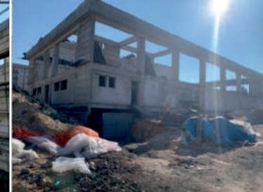
Oğuzeli İlçesi Yüzme Havuzu Yapımı
