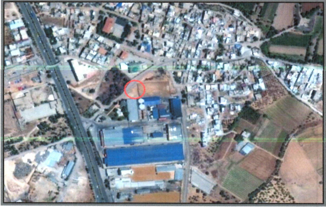
Resim: Yeşilkent mahallesi sınırları içerisindeki trafo kurulacak alanlar.
