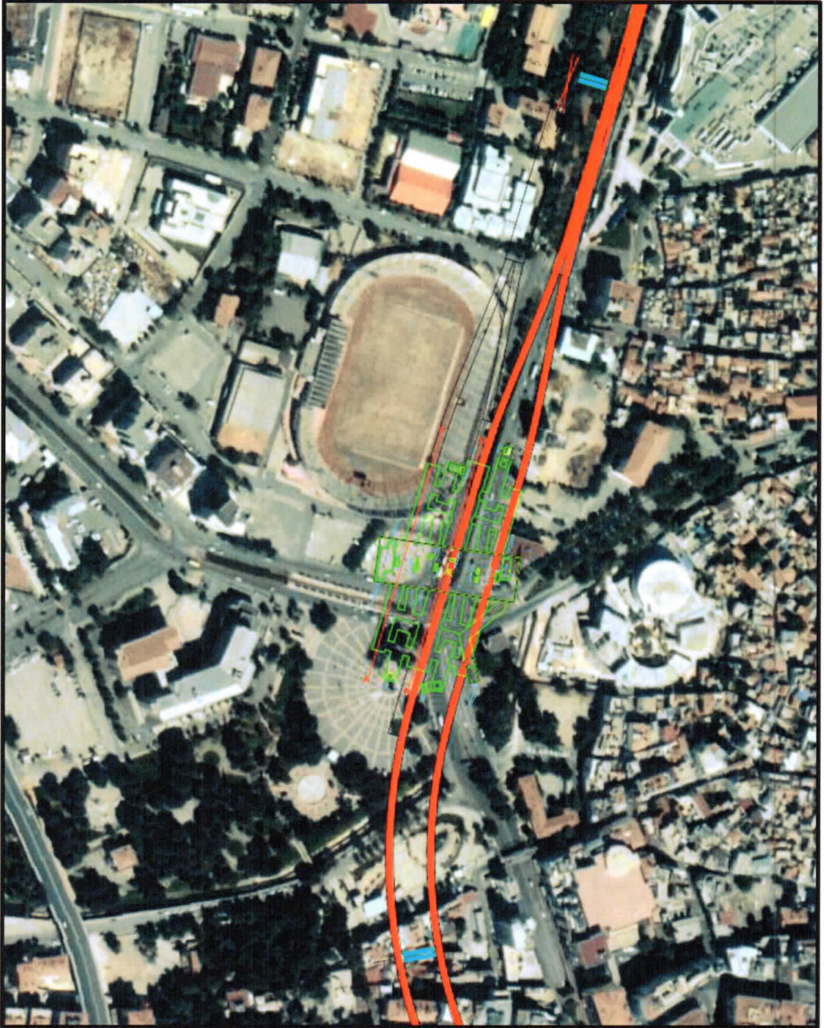
Şekil 5 Millet Bahçesi İstasyonu
