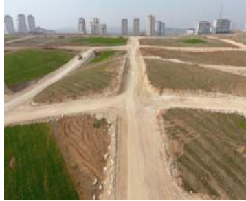
Beştepe Mah. İmar Yolu Çalışması
