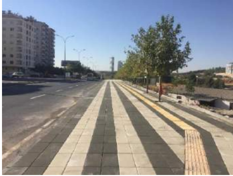
İbrahimli Mahallesi Gölgecik Kavşağı Kaldırım Çalışmaları
