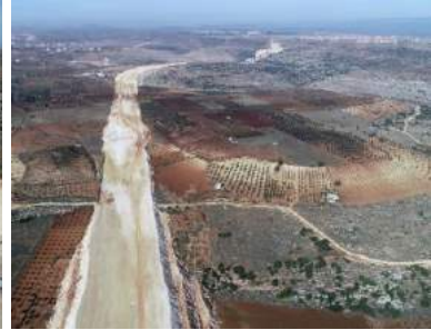
Kuzeyşehir 10,5 Km Yol Açma Çalışmaları.
