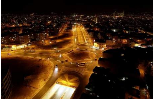
Mehmet ŞİMŞEK Köprüsü Kavşağı Aydınlatma
