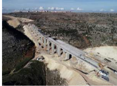
Kuzeyşehir Viyadük Çalışması
