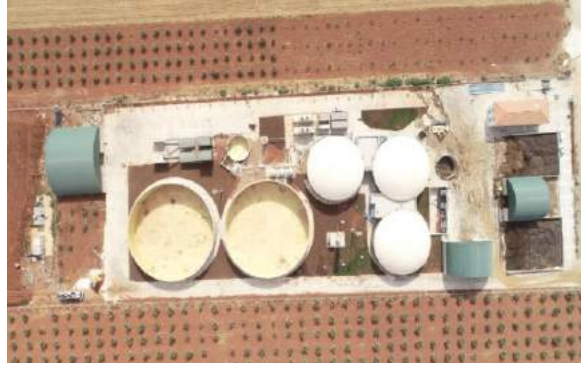
Oğuzeli Merkezi Biyogaz Tesisi
