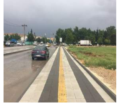
Şehit Ömer Halisdemir Bulvarı Kaldırım Çalışmaları
