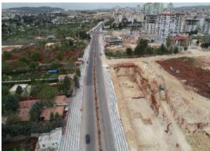
Ahmet ŞİRECİ Bulvarı Kaldırım Çalışmaları
