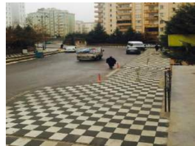
Akkent Mahallesi 420 Nolu Cadde Kaldırım Çalışmaları
