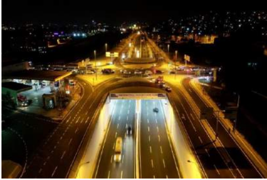
Mezarlık Kavşağı Aydınlatma
