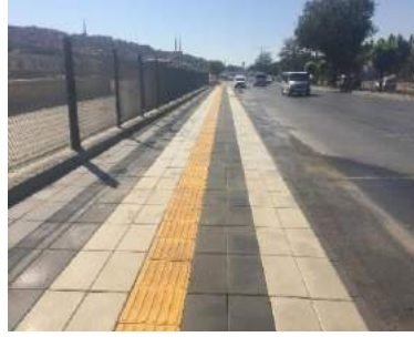
(D 400) İpek Yolu Kaldırım Çalışmaları
