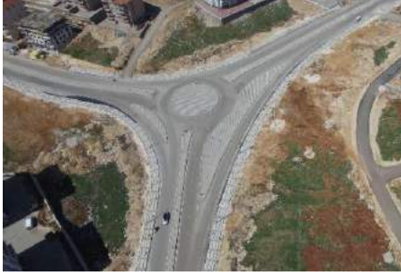
Çagdaş Mahallesi 72 Nolu Cadde Kaldırım Çalışmaları
