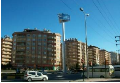
Şehrin Muhtelif Yerlerinde İletişimi Daha İyi Sağlamak İçin Gsm Operatörlerine Ait 8 Adet Baz İstasyonu Kurulumu Yapılmıştır.
