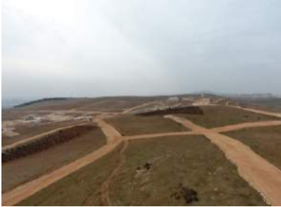
Biriketçiler Sitesi İmar Yolu Çalışması
