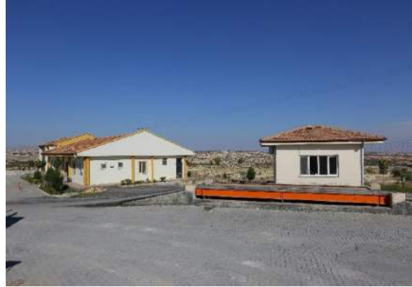
Nizip Katı Atık Sahası
