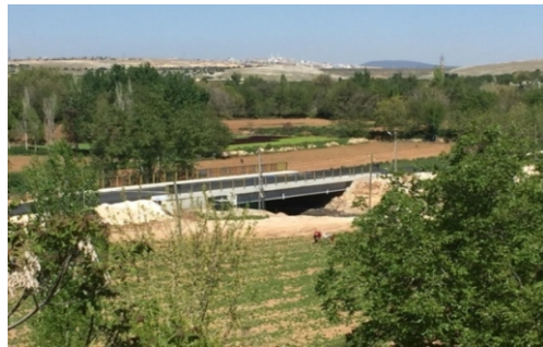
Bayramlı Mahallesi Köprüsü
