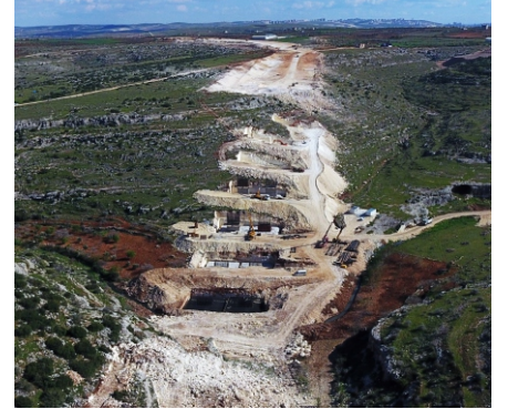
Kuzeyşehir Yol Çalışması
