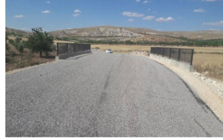
Yalangoz Mahallesi Köprüsü
