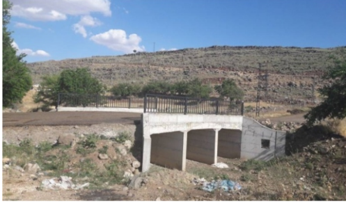
Sarıt Mahallesi Köprüsü
