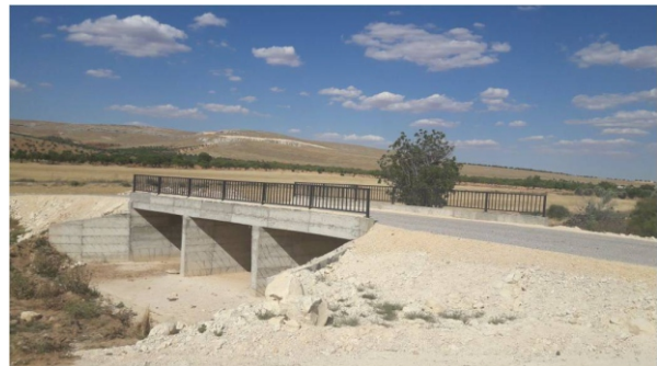
Kerer Mahallesi Köprüsü
