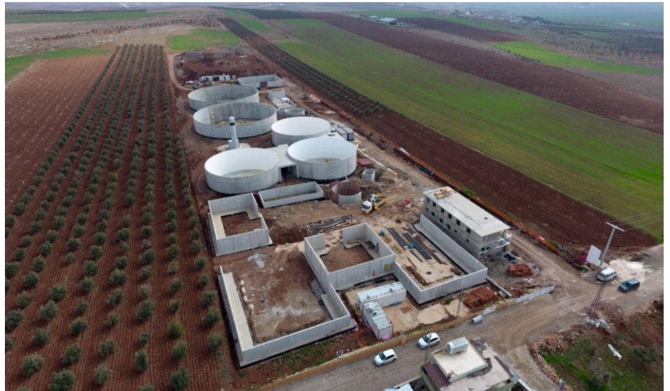
Oğuzeli Merkezi Biyogaz Tesisi
