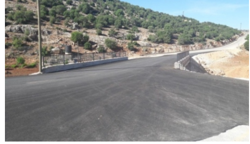
Karasakal Mahallesi Köprüsü
